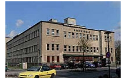
Fassade zur Wurzener Straße, 2007
